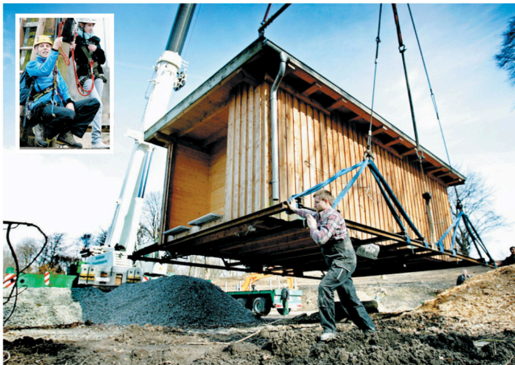
Auf Reise: Gestern Morgen wurde die gut sieben Tonnen schwere Hütte des Kletterparks am Johannisberg versetzt. Sie musste umgestellt werden, weil an ihrer Stelle die neue Zufahrtsstraße gebaut wird. Geklettert – wie oben im kleinen Foto – wird wieder ab Samstag, 27. März. FOTOS: SARAH JONEK
