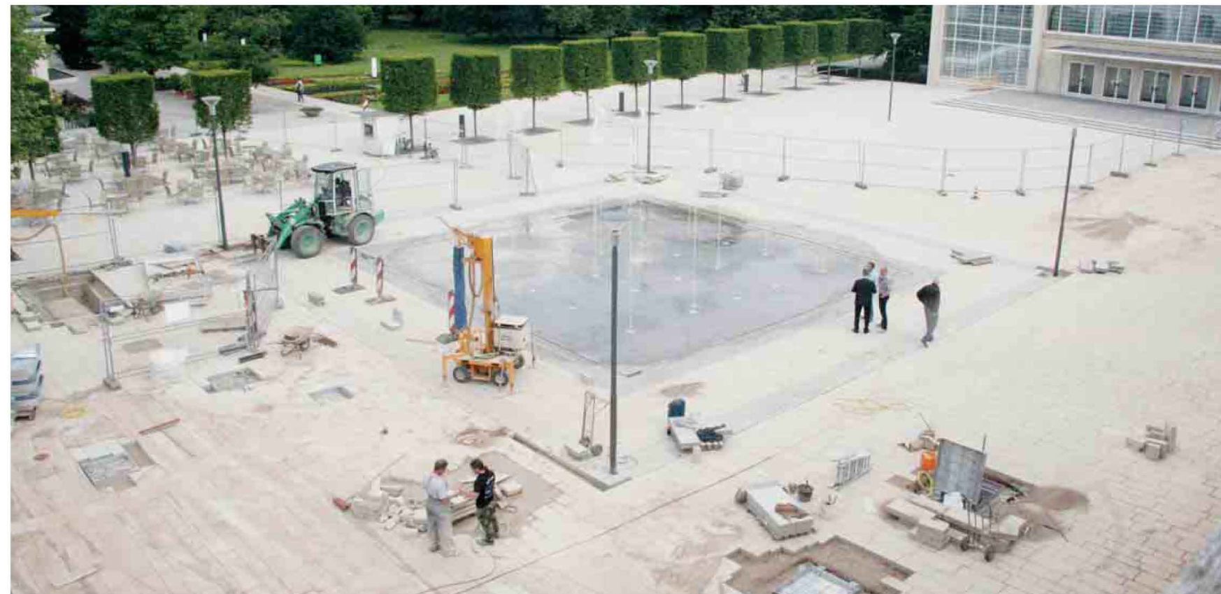
Ein gutes Zeichen: Meterhoch schießen die Fontänen aus den Düsen des neuen Brunnenspiels – Wasser flutet das dunkler gepflasterte Carrée.
