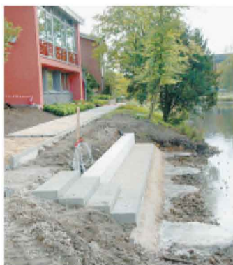
Im Rohbau: Die zum Steg führenden Stufen sind schon erkennbar, die runden Tragpfeiler davor in den Sennestadtteich eingelassen.
