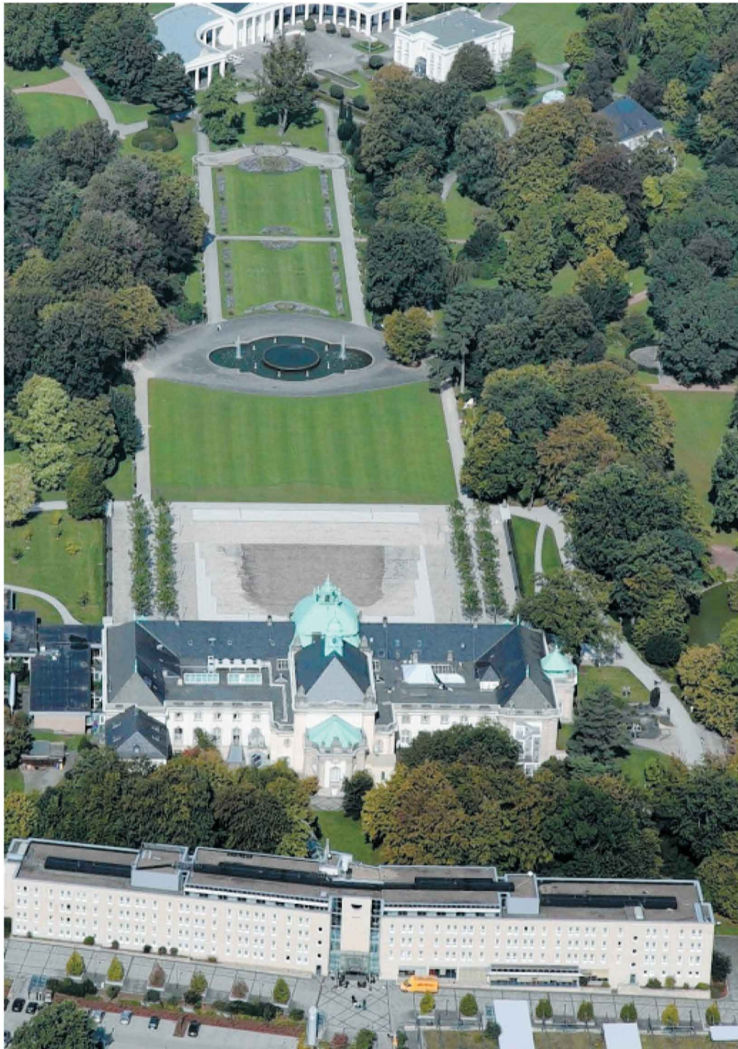
Die Hauptachse des Kurparks: Auf halber Strecke zwischen Kurhaus (unten, am Bildrand vorgelagert das Arcadia-Hotel) und der Wandelhalle (oben) liegt der Fontänenplatz, der nun grundsaniiert werden soll. Gleichzeitig wird es einen neuen Mittelweg über die Rasenfläche im Kern des Parks geben. FOTO: EDWIN DODD
