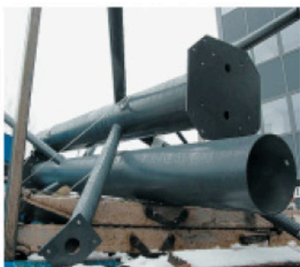
Wichtig: die beiden schweren Stahlträger, die die Seeterrassen stützen.
