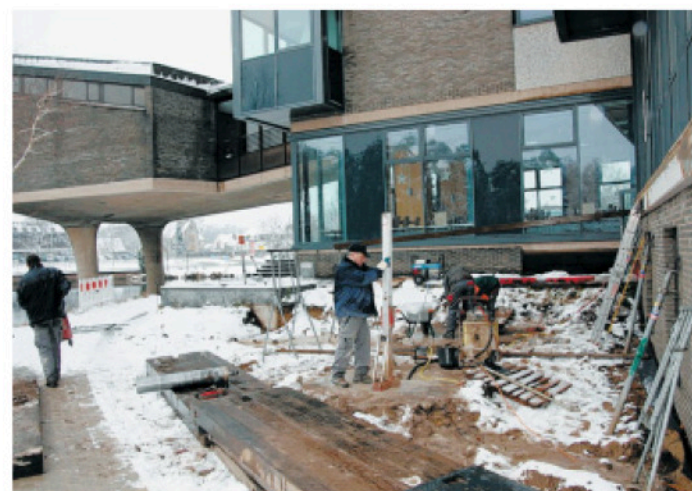
Vorarbeiten: Vor dem Anbringen der zwei Terrassen-Elemente wurden zwei große Löcher für die Verankerung in den Boden gebohrt.
